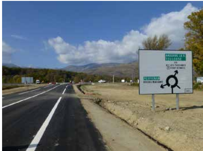
Les bordures puis les éléments de signalisation sont mis en place - © DREAL Languedoc-Roussillon
