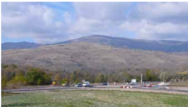
Vue sur le nouveau giratoire de la RN20 depuis le pont de Livia (RD68) © DREAL Languedoc-Roussillon
