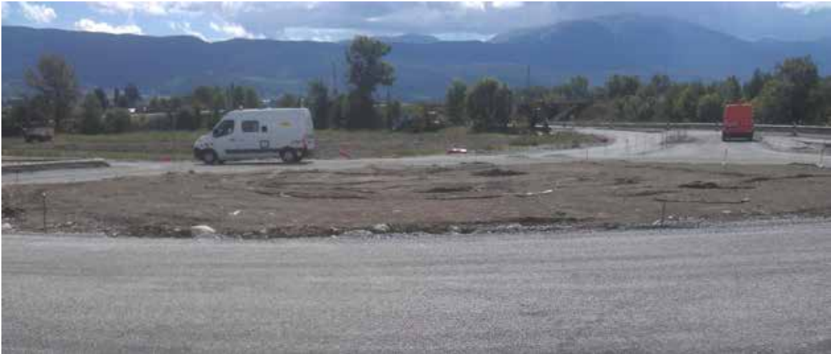
Des chaussées provisoires avant l'aménagement définitif - © DREAL Languedoc-Roussillon
