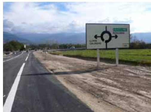
Vue sur le giratoire de la RD68 depuis le nouveau barreau routier - © DREAL Languedoc-Roussillon
